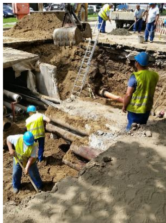
1. ábra. Csőtörés javítása közúton (forrás: internet_5)
