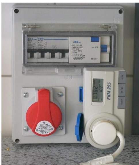
5. ábra: EKM 265 típusú energiafogyasztás-mérő Forrás: saját felvétel
